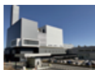
被日本全国70多家设施采用 废弃物处理与发电设施
