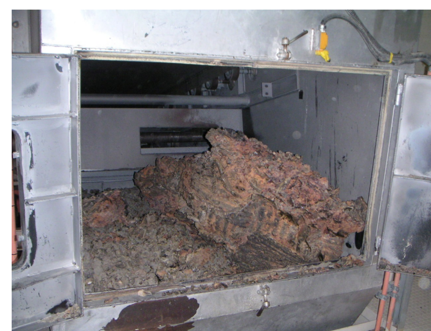
石炭ボイラで生成したクリンカの大塊 (左) クリンカ生成を抑制する混炭レシピ (右)
