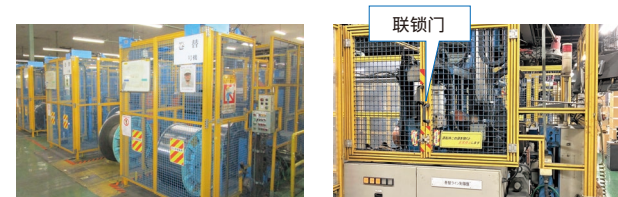
一项为降低制造工序中卷入复绕机活动部位的风险而采取的举措 焊接事业部门茨木工厂案例 (推进在活动部位安装具备联锁功能的防护栏等)
